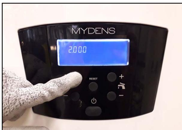
Una volta terminata la programmazione del menu “2.000” premere il tasto “+” del riscaldamento.
